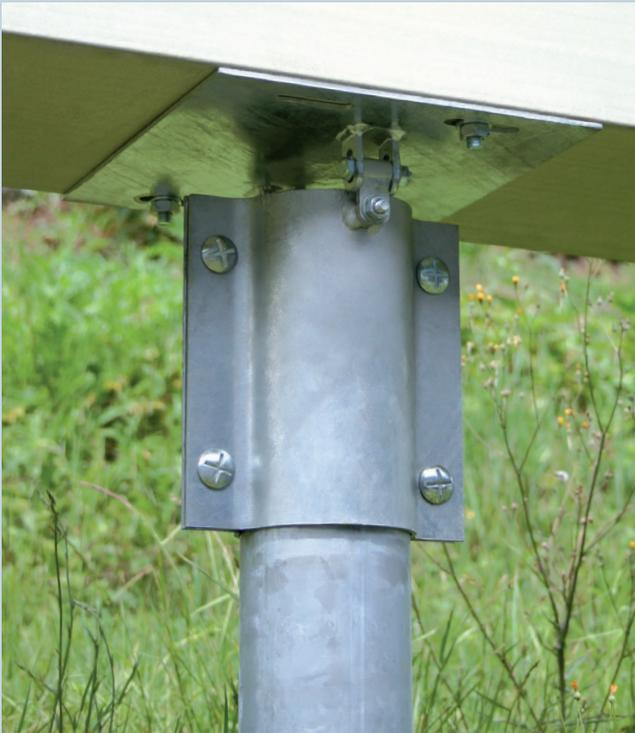
Placa de cabezal móvil ajustable en 3 direcciones
