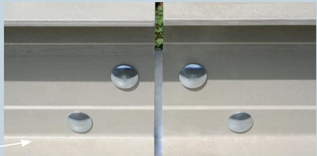
Tornillos de cabeza redonda, junta de dilatación mantenida
