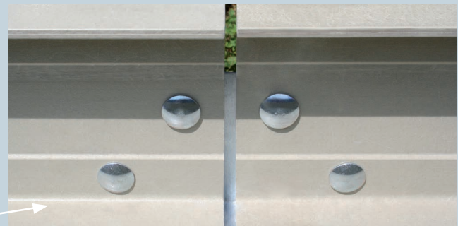
Flachrundkopfschrauben, eingehaltener Ausdehnungsspalt
